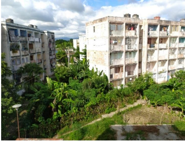
Figura 37: Cultivos alrededor de edificaciones.
