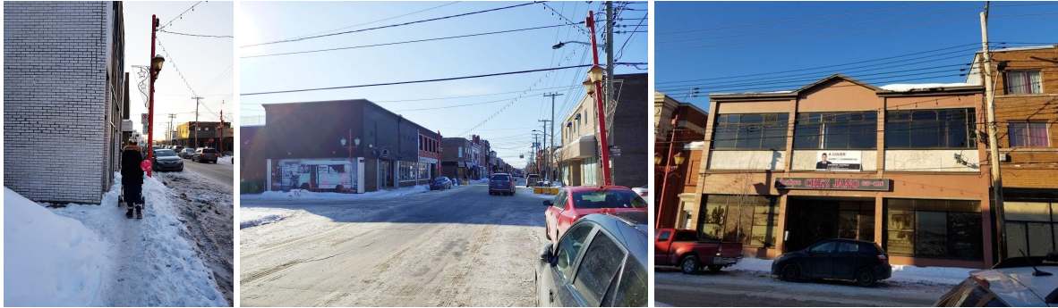
Figure 13. État actuel de la Rue Notre-Dame : Mobilité déficiente (1), Circulation automobile prédominante (2) et Locaux commerciaux et résidentiels vacants (3) (2020).
