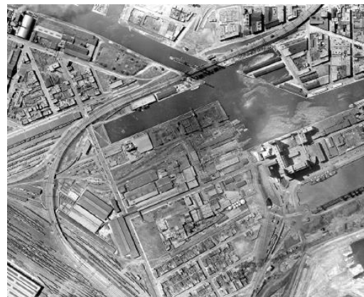
Figure 2-6: 1925 - Photographie aérienne - Archives de la Ville de Montréal
