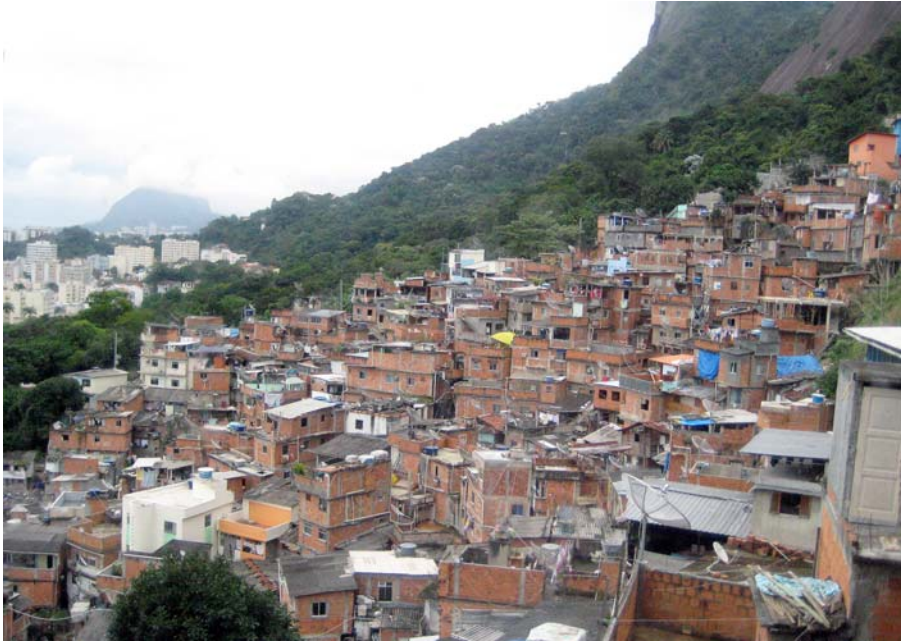
Fig. 5. Lieu d'intervention : La favela Santa Marta
