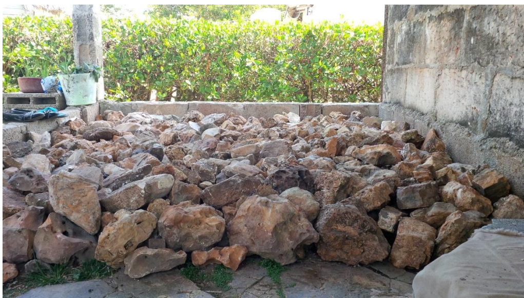
FIGURA 12 PROCESO DE ELEVACIÓN DEL NIVEL DE PISO. FUENTE: DEL AUTOR
