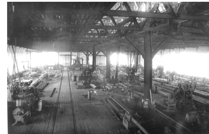
Figure 4 : Dominion Bridge, intérieur de l'atelier principal, vue de l'extrémité sud
